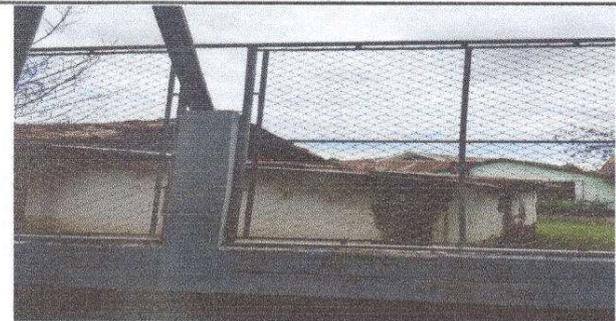
Foto: 5 ESTA MALLA SE CAMBIÓ PORQUE ESTABA EN MAL ESTADO
